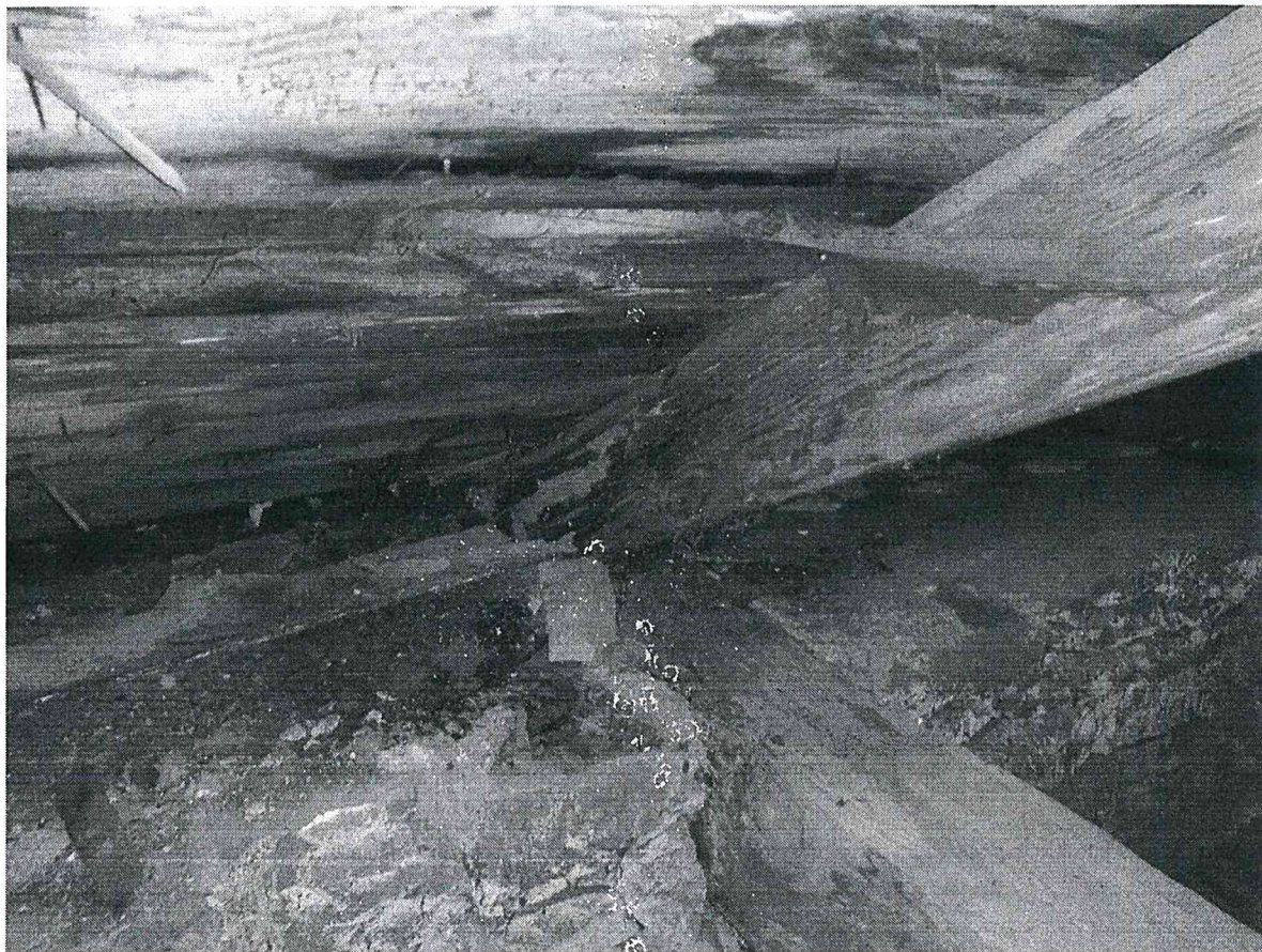
Fot.8. Połączenie krokwi z kulawką
