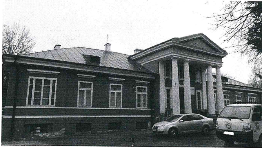
Fot. 2.2. Bryła budynku, elewacja północna.
