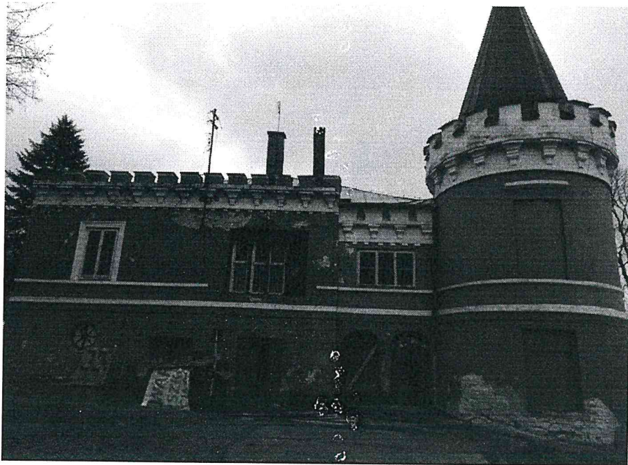
Fot. 2.5. Elewacja zachodnia.
