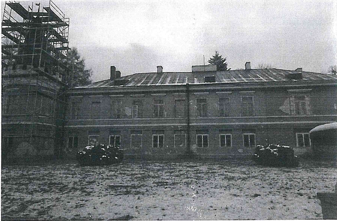
Fot. 1. Pałac w Tarnogórze k/ Izbicy z 1840 r. Stolarka okienna i drzwi. Stan zachowania przed renowacją. Widok ogólny elewacji pałacu od południowej strony. Grudzień 2023 r. Fot. T. Sokal
