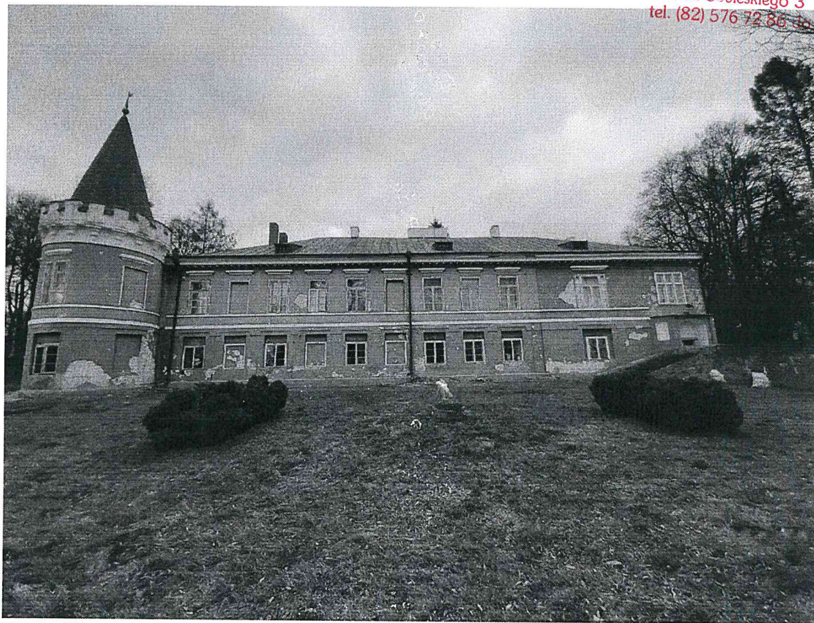
Fot.2. Elewacja ogrodowa
