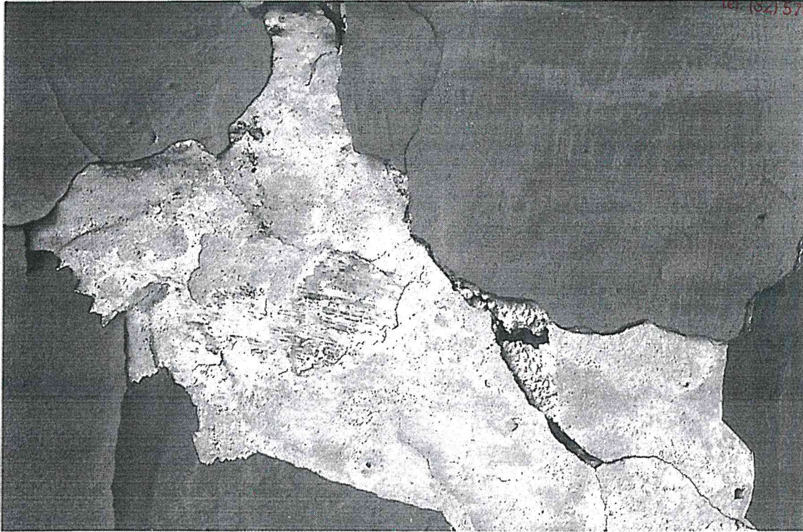
Fot. 17. Pałac w Tarnogórze k/ Izbicy z 1840 r. Stolarka okienna i drzwi. Stan zachowania przed renowacją. Środkowa część blendy. Widoczny jest szary kolor na ochrze żółtej, świadczący o malowanym oknie iluzjonistycznym. Marzec 2024. Fot. T. Sokal
