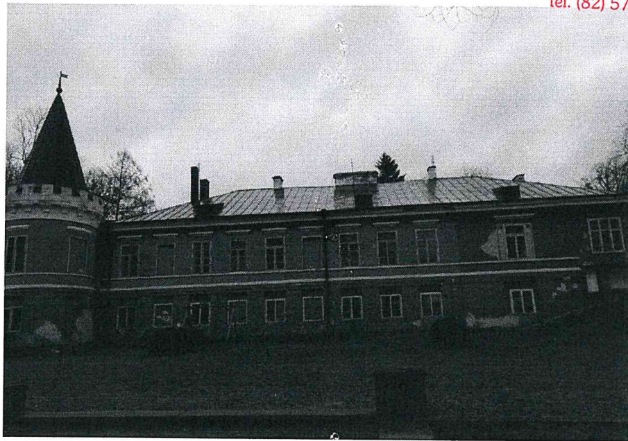
Fot. 2.4. Elewacja południowa.
