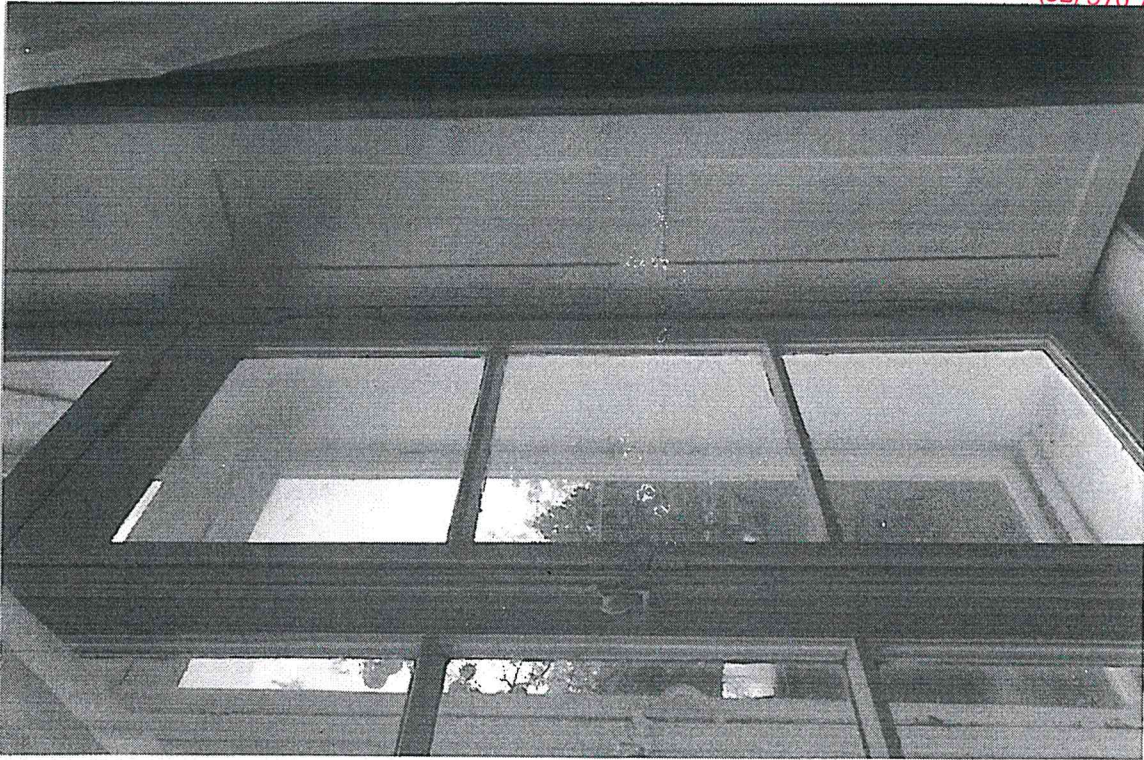
Fot. 23. Pałac w Tarnogórze k/ Izbicy z 1840 r. Stolarka okienna i drzwi. Stan zachowania przed renowacją. Okno od wewnątrz z rumowo-płycinową okiennicą. Grudzień 2023 r. Fot. T. Sokal
