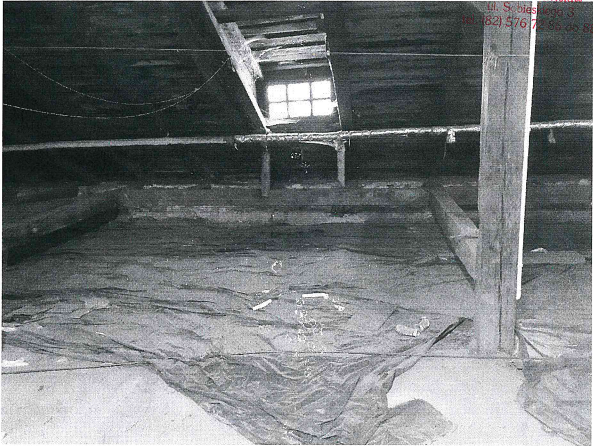
Fot.5 Tymczasowe zabezpieczenie pod przeciekającym pokryciem.
