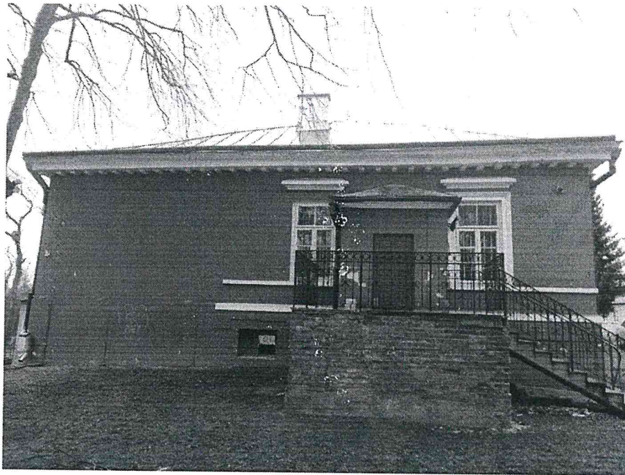
Fot. 2.3. Elewacja wschodnia.
